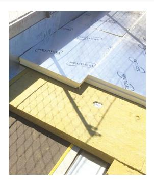
Rocterm Coberlan feuilluré est un panneau isolant en laine de roche non porteur support d'étanchéité pour mise en œuvre sur support acier ou bois en qualité d'écran coupe feu. Afin de prévenir le passage des gouttelettes enflammées, le panneau est feuilluré sur les 4 côtés.
